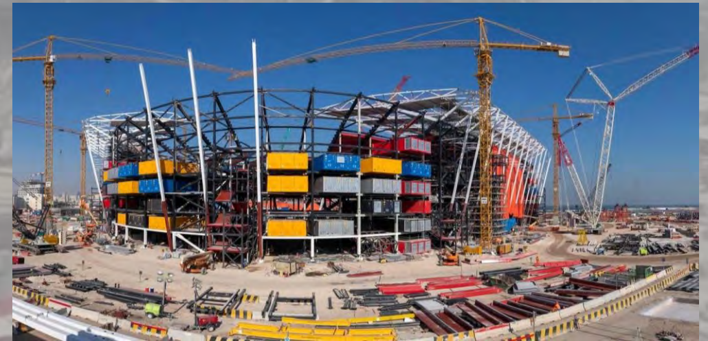
Stadion aus Containermodulen
